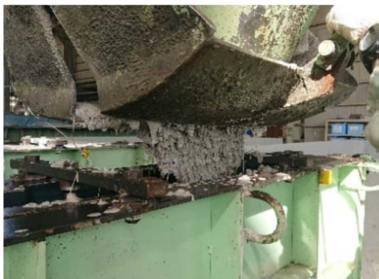
<製造状況一同材料の打込み状況>
